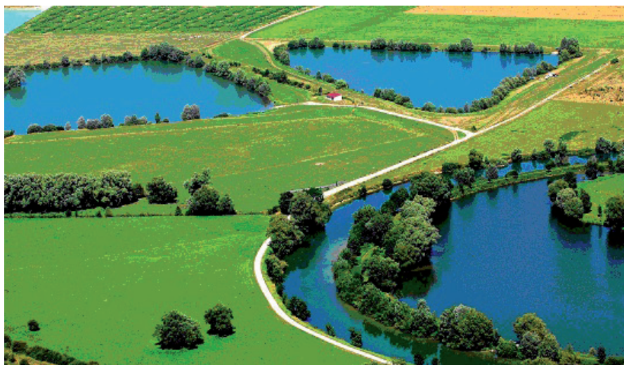
Vue aérienne : la Meuse, le canal et les étangs (photo J-M PERRAUX)
