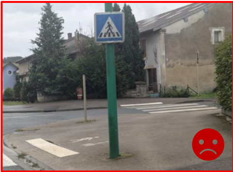
Simple marquage sur trottoir à Haudainville
