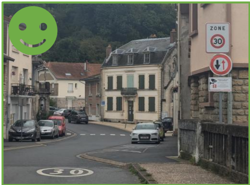
Dun-sur-Meuse : Z30 avec marquage et écluse
